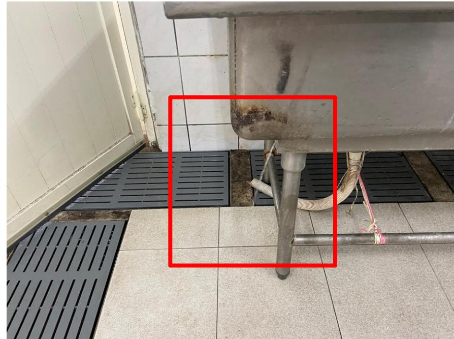
水槽破損漏水
